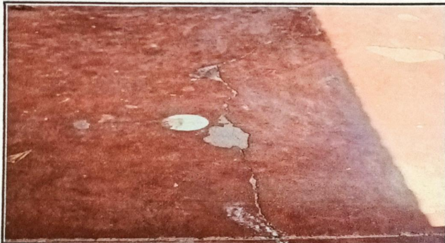
Foto1: Sustrucción de piso cerámico
