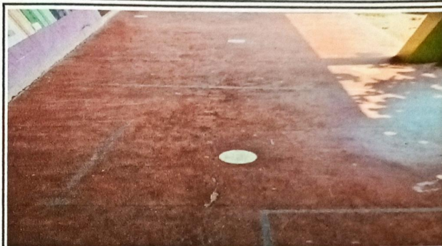
Foto 2: Sustrucción de piso cerámico
